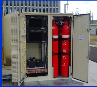
E-2500 2台による 5kWシステム設置例
