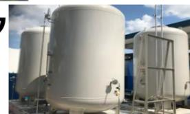
低圧で水素を貯蔵します。水素ステーション用及び燃料電池発電装置用として利用。
